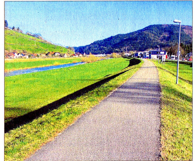
Die zukünftige Ortsumfahrung in Haslach wird im Westen mit einer Brücke geplant. Foto: RP Freiburg
